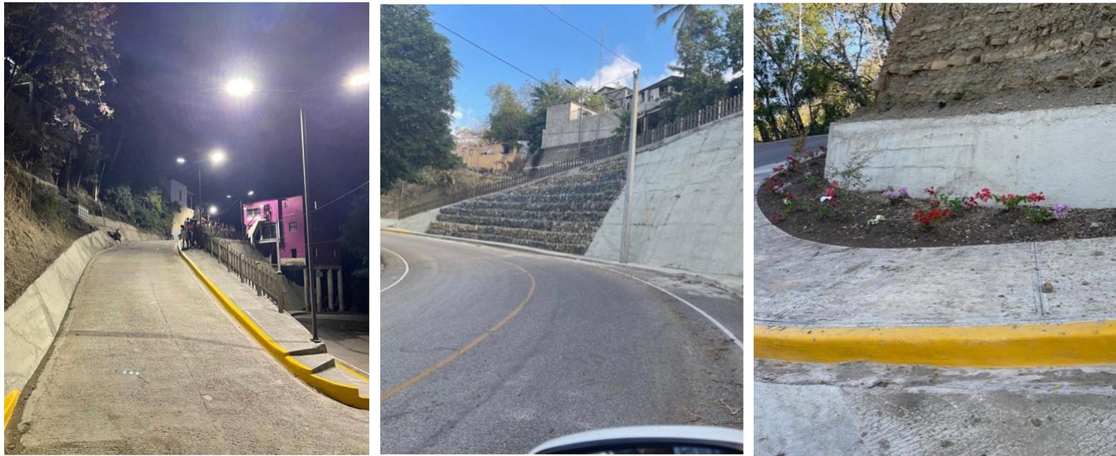
Concluye con éxito el remozamiento de la entrada al importante sector el Tanque, esta extraordinaria obra se tomó un extenso tiempo para su conclusión debido a los tipos y la calidad de los trabajos ahí realizados, incluyó muro de contención vaciado y de gaviones, iluminación, barandas, construcción de badenes, espejo de seguridad, seguimos avanzando, resolviendo las necesidades más perentorias de nuestro municipio con trabajos de alta calidad que garantizan su perdurabilidad.
